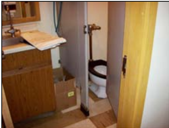
Floor Finishes: Replace Vinyl Asbestos Tile (VAT)
